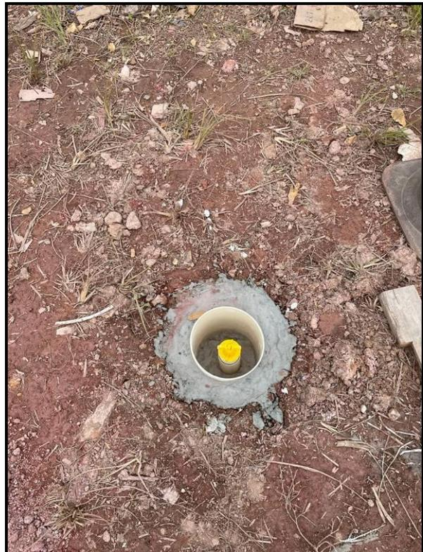
Foto 4: Poço de Monitoramento de vapor instalado.
